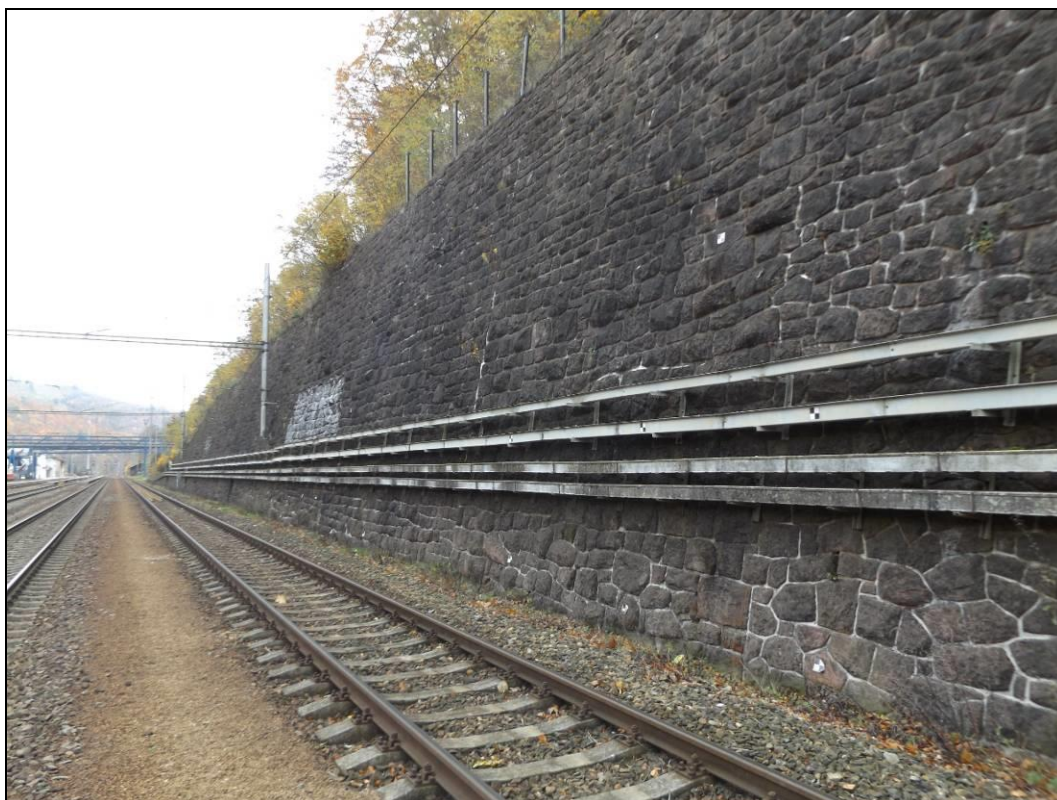
Obr. č. 8 – pohled na úsek, kde zeď dosahuje nejvyšší světlé výšky, spárování zdiva je zachovalé ojedinelé jsou ve spárách uchyceny náletové rostliny
