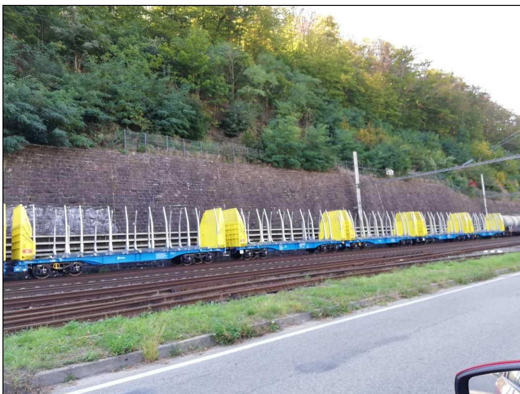
Obr. č. 11 – pohled na zeď v místě její nejvyšší světlé výšky, na koruně zdi byl v roce 2016 vybudován záchytný plot, který brání pádu horninových fragmentů do prostoru kolejiště
