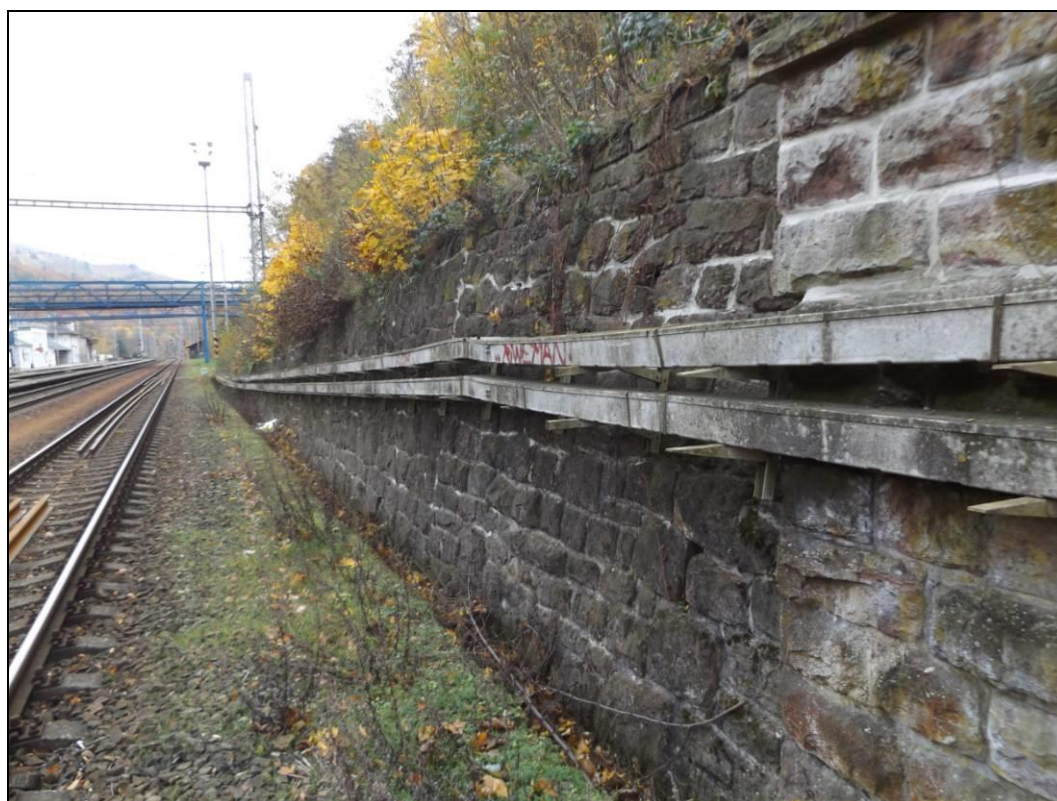
Obr. č. 7 – pohled na úsek zdi s nižší světlou výškou a s příkopem v patě zdi, příkop je silně zanesený organickými zbytky a antropogenním materiálem.
